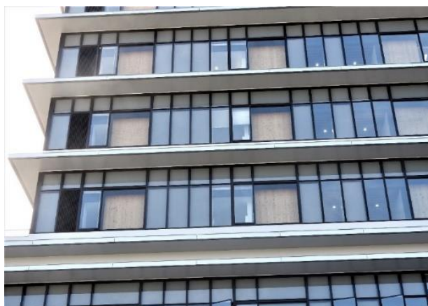
事例4 CLT耐震パネルを120枚使用
