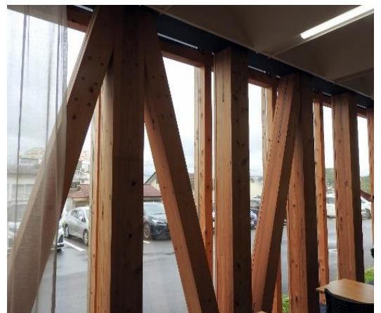
筋違と構造柱は外壁面より少し内側
