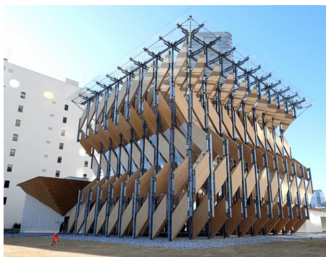
CLT PARK HARUMI これを蒜山に移築
